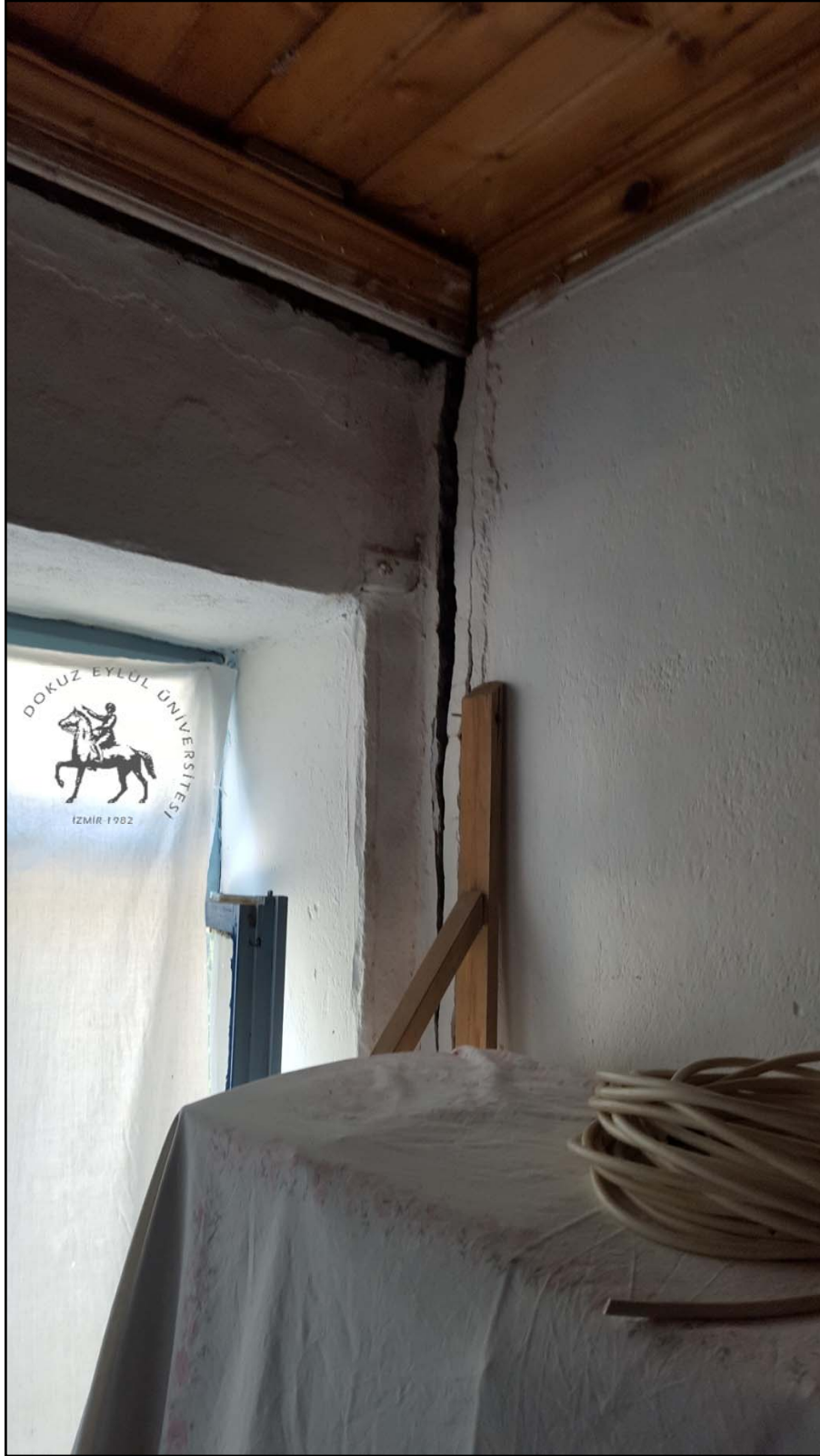
Foto 1: Bozköy'de hasar gören iki katlı yığma (kerpiç) yapının üst kat odasının dış cepheye bakan köşesinde ve tavan kaplaması arasında oluşan derin çatlağın görünümü
