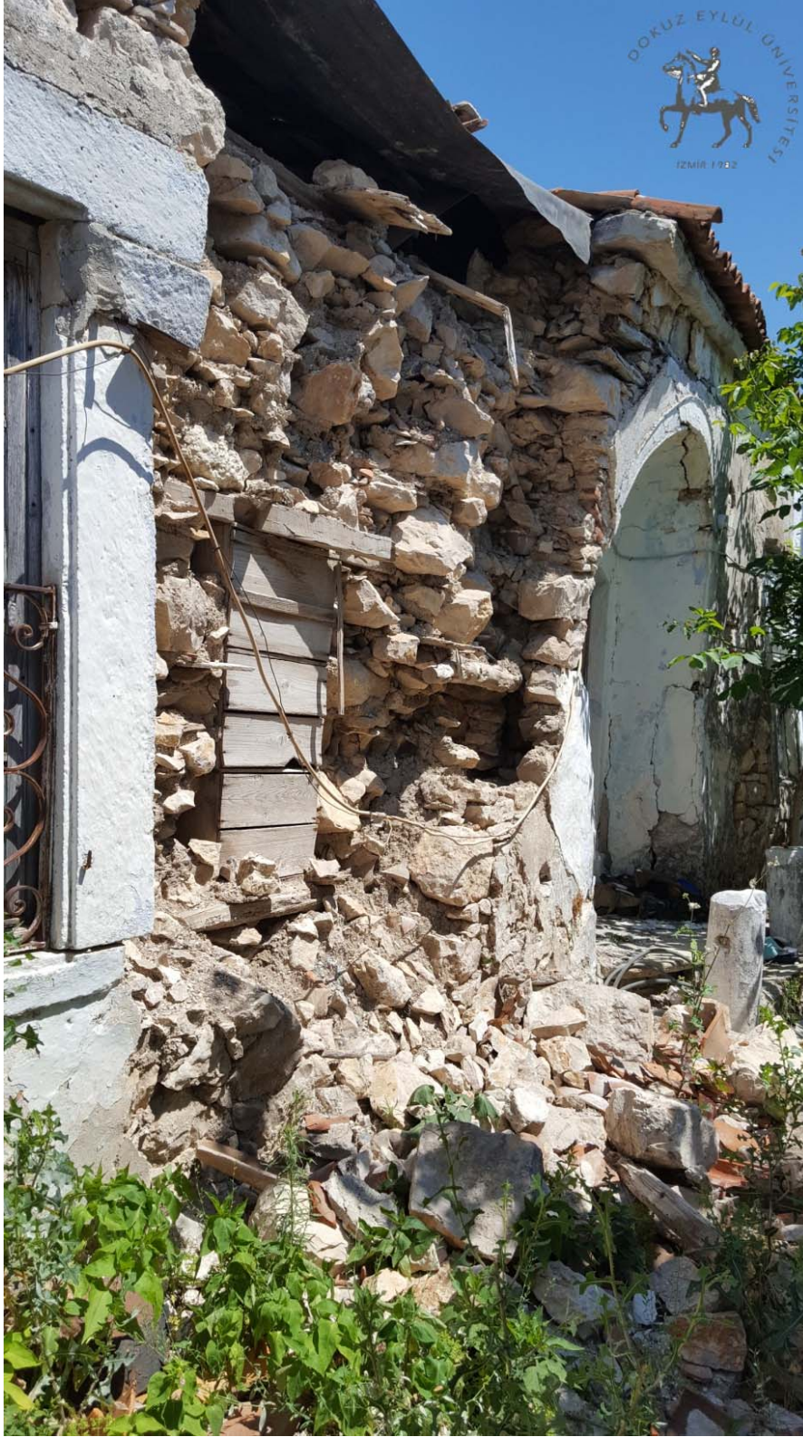
Foto 3. Kösedere köyünde yığma taş yapıda duvar yıkılması ve yapı girişindeki kemerin üzerinde oluşan çatlağın görünümü
