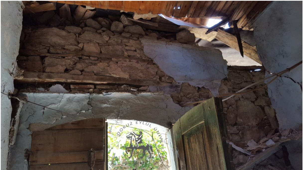
Foto 6. Kösedere'deki eski yığma (kerpiç) yapının duvarında oluşan kısmi yıkılma ve sıva düşmesi, duvardaki çatlak ile tavadaki ahşap döşeme kirişinde oluşan ayrılmanın görünümü
